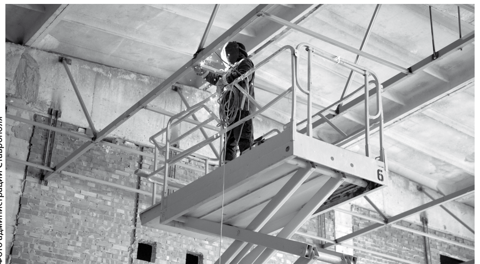
На улице Чапаева возвели каркас новой школы
