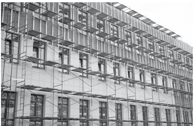
Фото администрации Ставрополя
