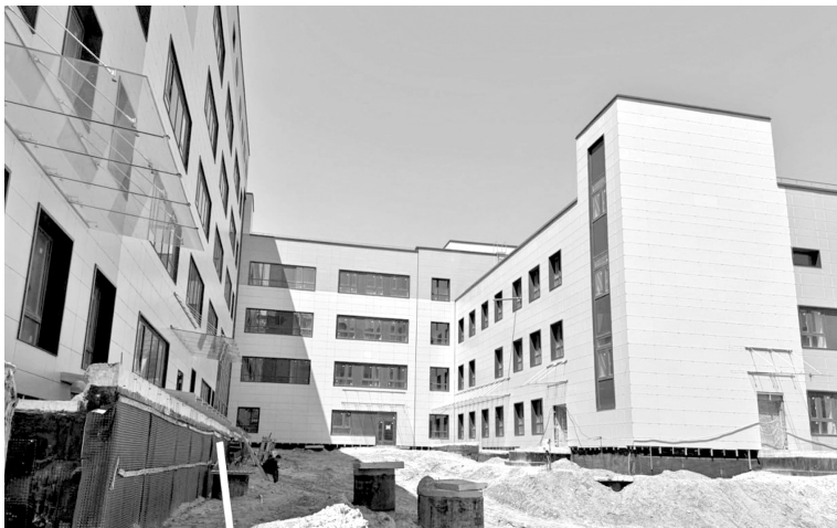
Ввод в строй онкодиспансера запланирован на 2028 год
