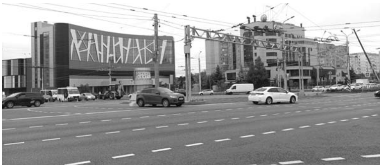
Реконструированный перекресток улиц Шпаковской и Доваторцев
