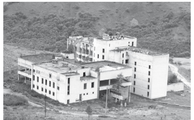
Заброшенные корпуса санаториев
